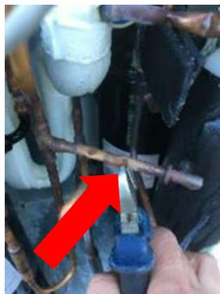
Couper doucement à l'aide d'une pince le tube de charge de la boucle C côté BP, afin de libérer le R744 contenu
