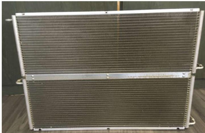
Bloc Gas Cooler complet démonté
