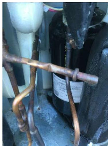
tuyauteries auxiliaire BP et HP
