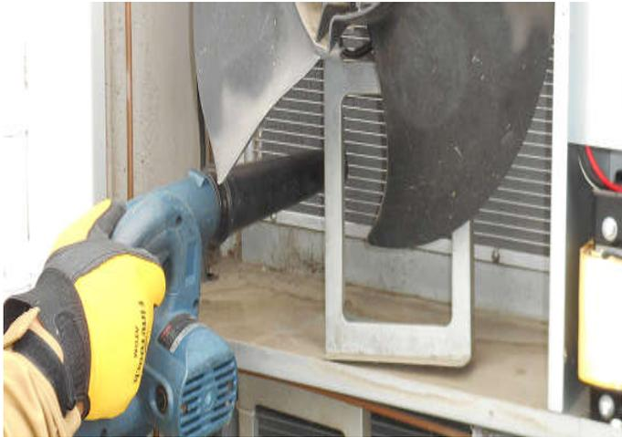
A l'aide d'un pulseur d'air ou d'un flexible sur bouteille d'azote souffler l'ensemble des Gas Cooler de l'intérieur vers l'extérieur afin de retirer le reliquat d'eau.
